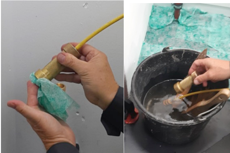
Foto 7 en 8 - Tijdelijke afdichting verwijderen
