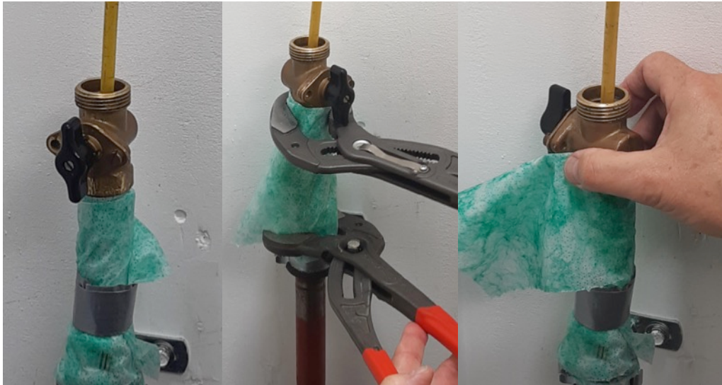
Foto 3, 4 en 5 - Plaatsing doekjes en losdraaien
