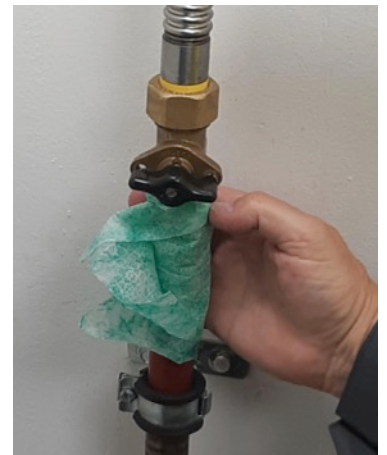
Foto 2 - Reinigen van buis/ koppeling
