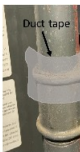
Foto 5 – Aanbrengen duct tape verbinding
