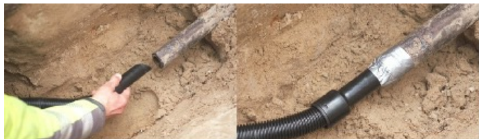
Foto 3 en 4 de aanbrengen (links) en aansluiten (rechts) asbeststofzuiger op de aansluitleiding
