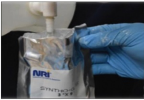
Foto 8 en 9 – Vullen en weken van syntho-Glass band
