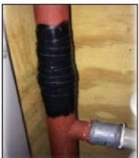
Foto 7 - Leiding met densoleenband aangebracht
