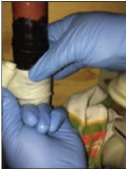
Foto 10 en 11 - Aanbrengen en aangebrachte Syntho-Glass band
