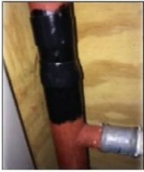
Foto 6 - Leiding met primer aangebracht
