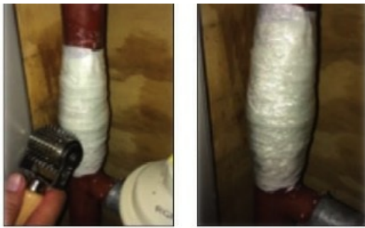
Foto 12 en 13 - Perforen compressie folie en lekreparatie uitgevoerd
