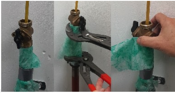
Foto 3, 4 en 5 - Plaatsing doekjes en losdraaien
