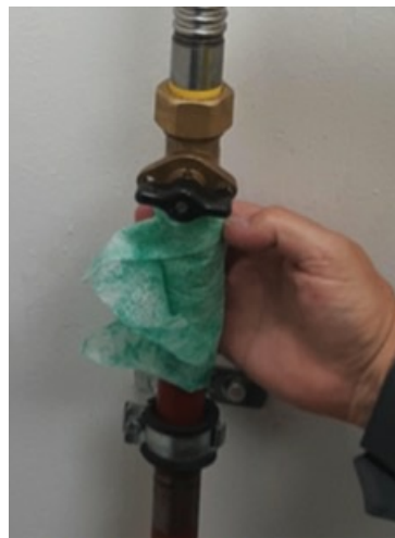
Foto 2 - Reinigen van buis/koppeling
