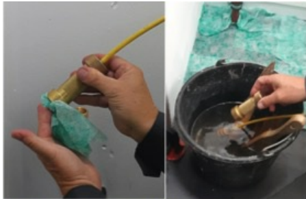
Foto 7 en 8 - Tijdelijke afdichting
