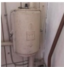
Figuur 1 Stijgleidingkast E-292
